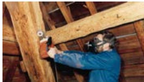
Marc entreprend de mécaniser le décapage en commençant par la décapeuse électrique à chaînes de tronçonneuses.
