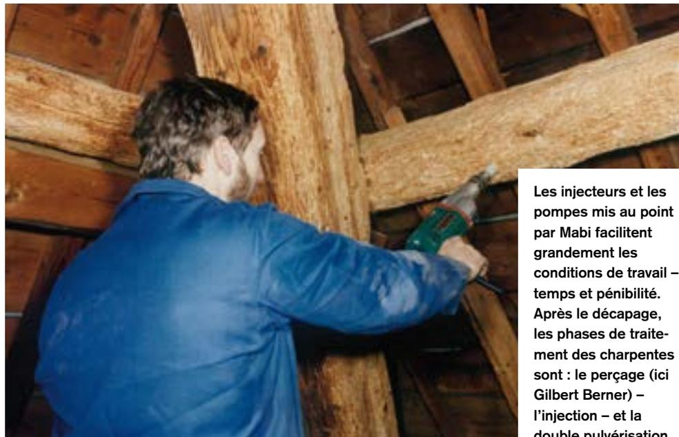
Les injecteurs et les pompes mis au point par Mabi facilitent grandement les conditions de travail – temps et pénibilité. Après le décapage, les phases de traitement des charpentes sont : le perçage (ici Gilbert Berner) – l'injection – et la double pulvérisation.
