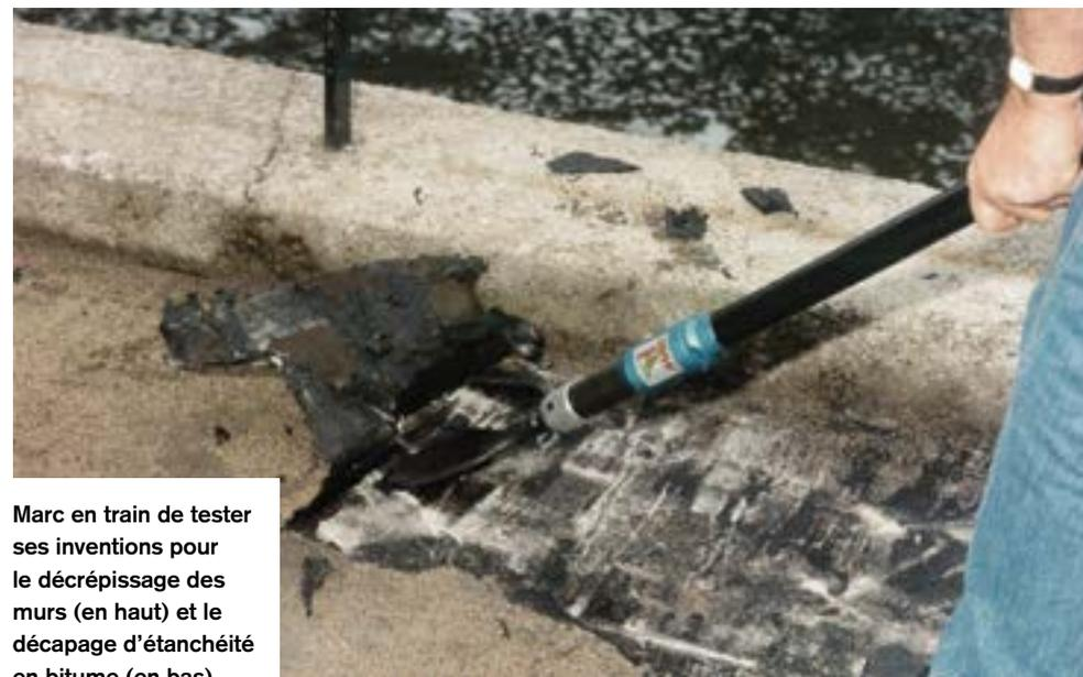
Marc en train de tester ses inventions pour le décrépissage des murs (en haut) et le décapage d'étanchéité en bitume (en bas).
